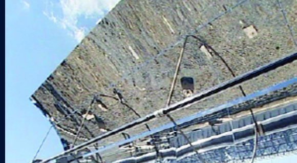
Parabolspiegel sammeln das Licht wie ein Brennglas auf den Röhren im Brennpunkt
