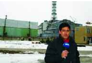
Der Sarkophag aus Stahl und Beton ist baufällig
