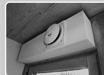
Neubauteile werden oft automatisch gelüftet. Aus der Abluft wird dabei wertvolle Wärme zurückgewonnen.
