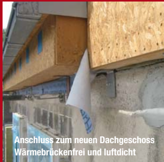
Wärmebrückenfreier Festereinbau
